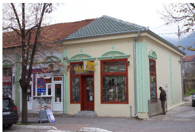
Slika 15 – Neadekvatan krovni pokrivač, agresivne reklame (dokumentacija autora)
