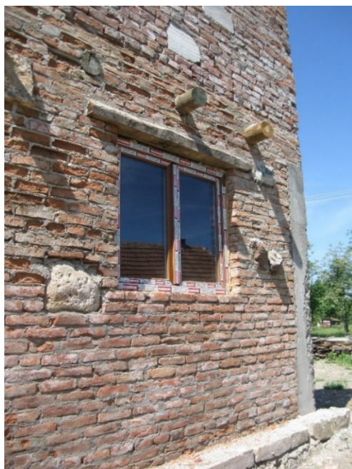
Slika 7 – Drveni natprozornik nasuprot PVC stolariji (dokumentacija autora)
