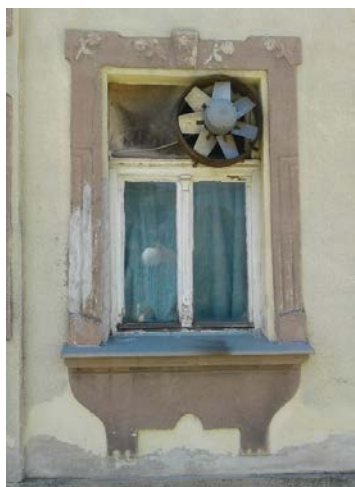
Slika 3 – Improvizovani klima uređaj (dokumentacija autora)
