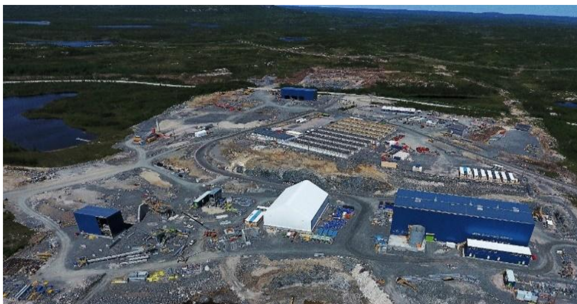
Slika 7. Whabouchi Lithium Mine površinski kop, Quebec, Kanada
