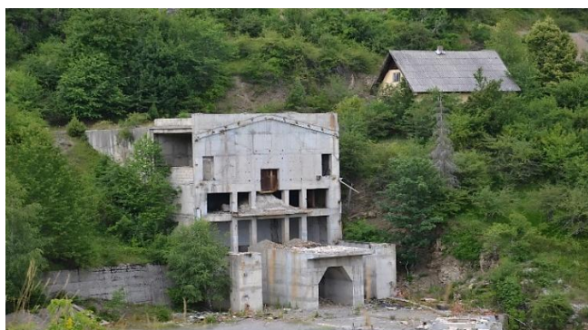
Slika 4. Ostaci postrojenja za PMS
