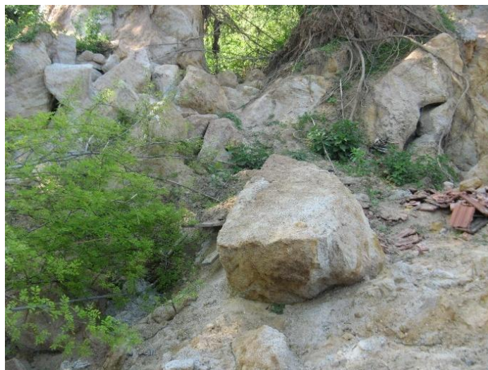
Slika 6. Blokovi odronjenog pješčara. (Foto J. Čomić, 2011)
