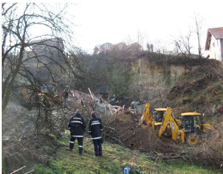
Slika 1. Subvertikalna zapadna kosina. (Foto: J.Čomić, 2010).
