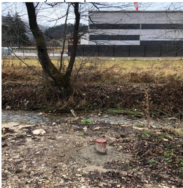
Slika 3. Prikaz ugrađenog–zaštićenog pijeziometra
